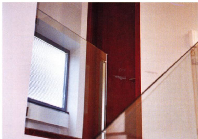
Slika 9: Detalj stubišnog prostora. A detail of the staircase.
