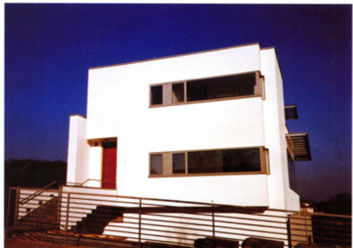
Slika 4: Zapadna (ulična) fasada. The west (street) elevation.
