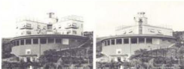
Fig. 11 A.Invernizzi: Villa Girasole rotation.
