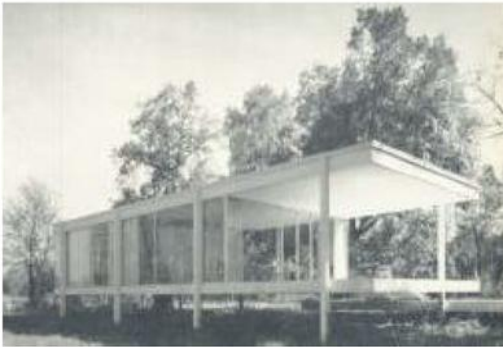
Fig. 9..Mies van der Rohe: Farnsworth House,1951.
