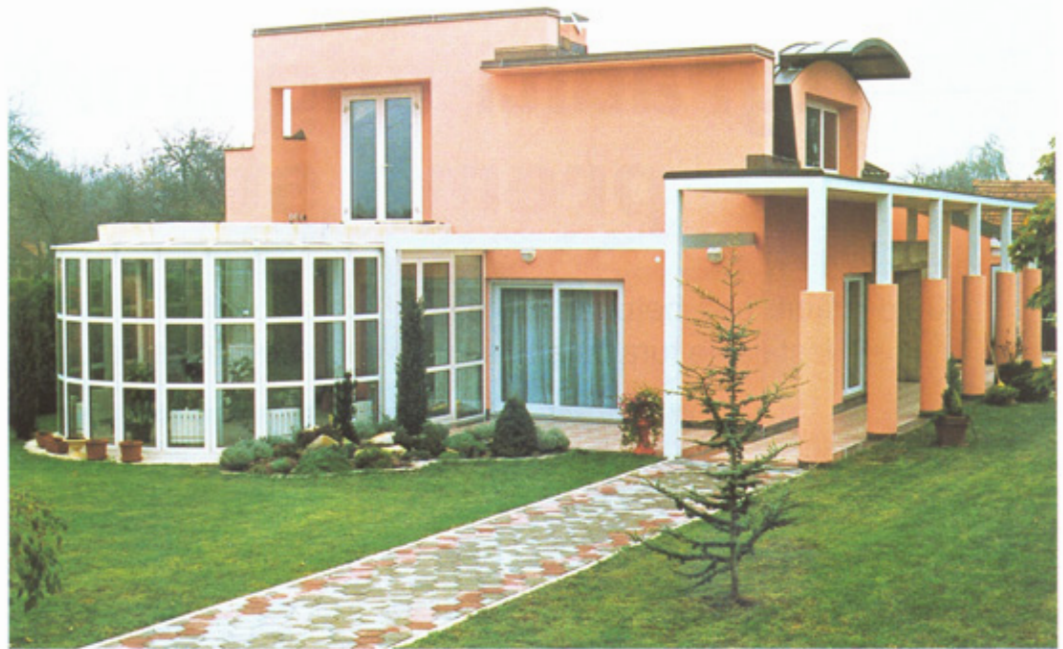
Obiteljska kuća "B&V Bilandžić" u Ivanić-Gradu: ista kuća (sl.1) nakon dogradnje i preoblikovanja. Obitelj je u međuvremenu postala peteročlana i sobnost se u kući sa 3 povećava na 5 soba. Prigodom dogradnje i adaptacije investitor je želio promijeniti i izgled kuće. - projekt : Lenko Pleština, 1996.
